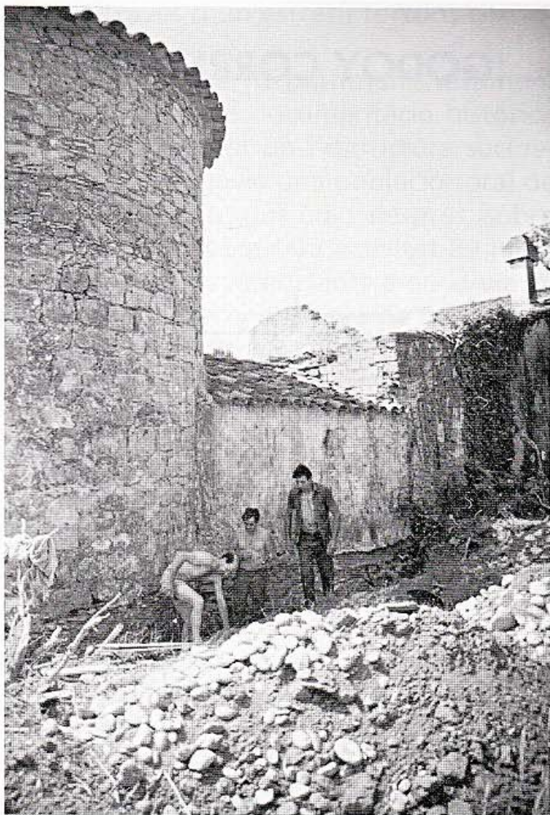
Recuperació i pavimentació del corriol de l'absis de la capella.
